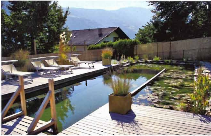
1-2. Due realizzazioni di Grünkultur Luther (Merano, BZ, tel. 0473/44.30.32; www.luther.it ): qui sopra si nota come la vasca di balneazione venga separata dalla zona di rigenerazione e filtrazione, dove sono fiorenti la microfauna e la microflora acquatica che fungono da depuratori. 3-4-5. Tre esempi di biopiscine naturali e suggestive di Piscine & Natura (Bergamo, tel. 035/25.93.55; www.piscinenatura.it ).
